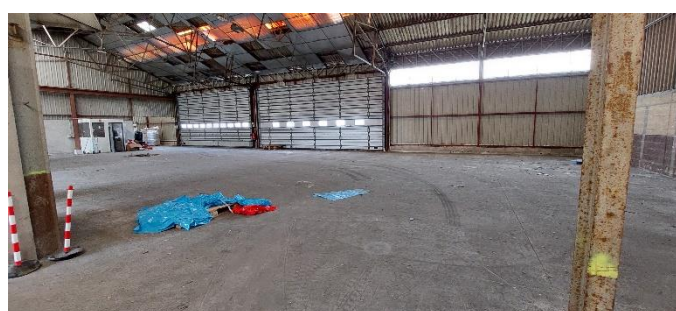
Absence de fosse de travail dans le hangar Dalle propre et récente
